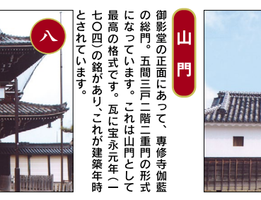
山門 御影堂の正面にあつて、專修寺伽藍の総門。五間三戸二階、重門の形式になっています。これは山門として最高の格式です。瓦に宝永元年（一七〇四）の銘があり、これが建築年時とされています。
