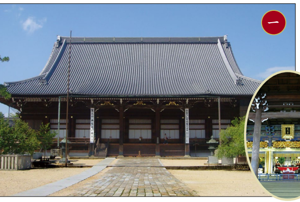
御影堂 昭和三十六年六月「重要文化財指定」 宗祖親鸞聖人の木像を中央須弥壇上に安置し、歴代人の画像を両脇におよび両余間に設置するお堂となっており、畳七百二十五枚が敷かれており、全国に現存木造建築の中でも五番目の巨大な堂です。正保二年（一六四九）の大火による伽藍焼失後、津藩から寄進された新境内地に建造されました。建立は寛文六年（一六六六）に上棟、延宝七年（一六七九）に落慶供養法要が行われました。純和様の手法で外観は地味に建てられていますが、内部の間取りは真宗寺院通規ですが、本願寺系の本堂と異なる点は、大間が横長になっていること、両余間の床が奥寄りのところ、一段高くなっていることです。これらが各末寺に影響を与え、寺院建築の特徴となりました。
